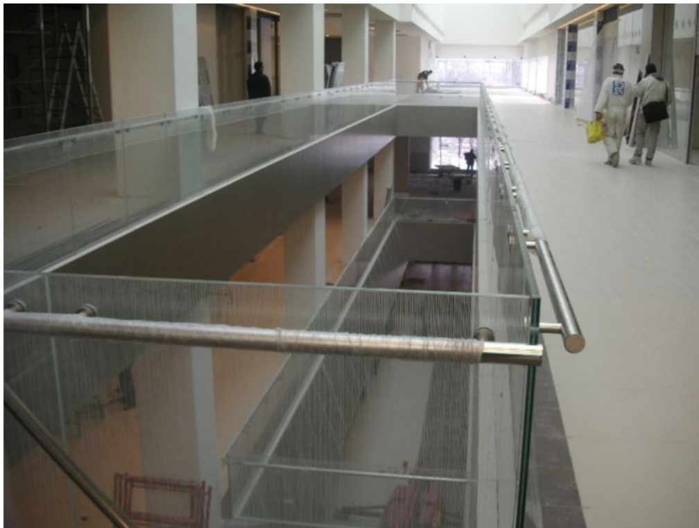
Сл. 4 Завршна фаза монтаже ламинатног стакла
