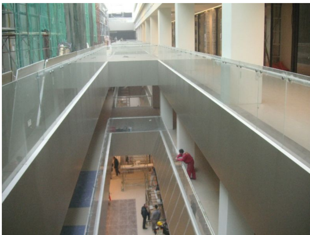
Сл. 5 Завршна фаза монтаже ламинатног стакла и касета од композитног панела
