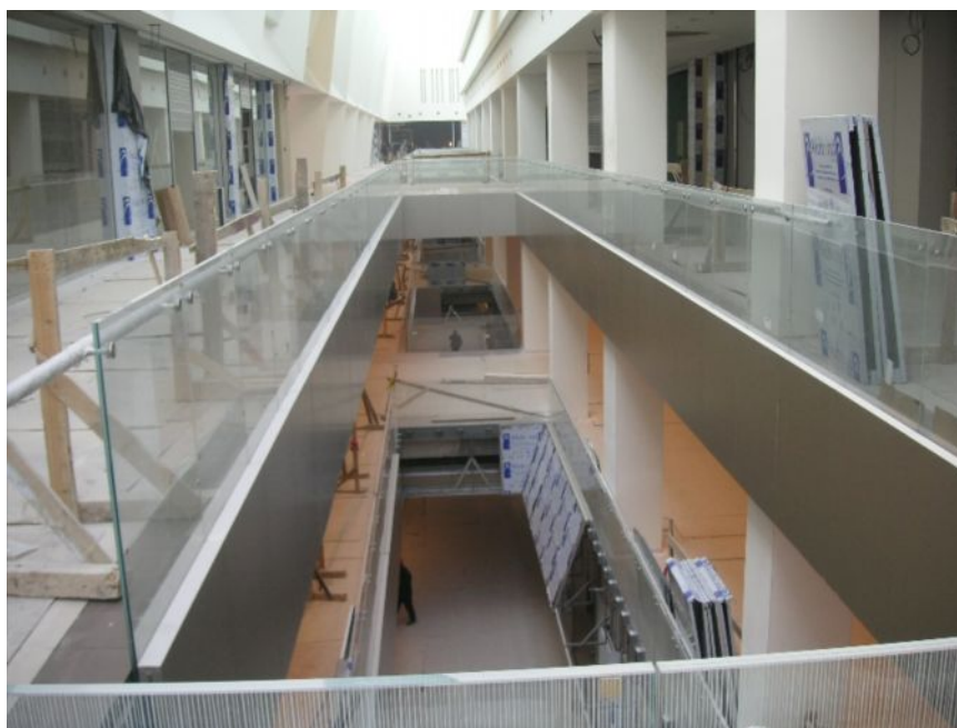
Сл. 3 Илустрација комбинације везивања ламинатног стакла и касета од композитног панела
