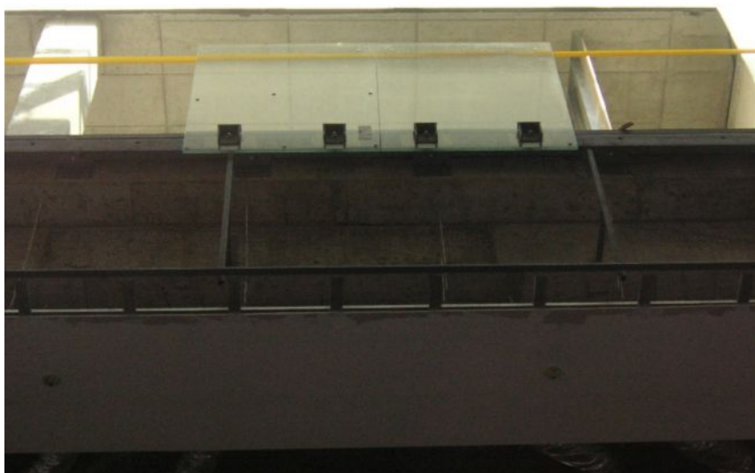
Сл. 2 Илустрација везивања ламинатног стакла система оградe атријума у тржном центру «УШЋЕ»
