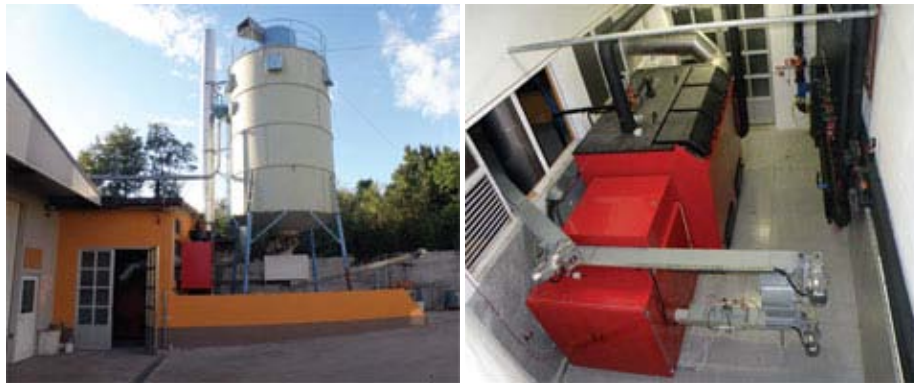
Слика 7. Сагоревање праха од медијапана и иверице; лево силос, десно котларница снаге 500 kW
