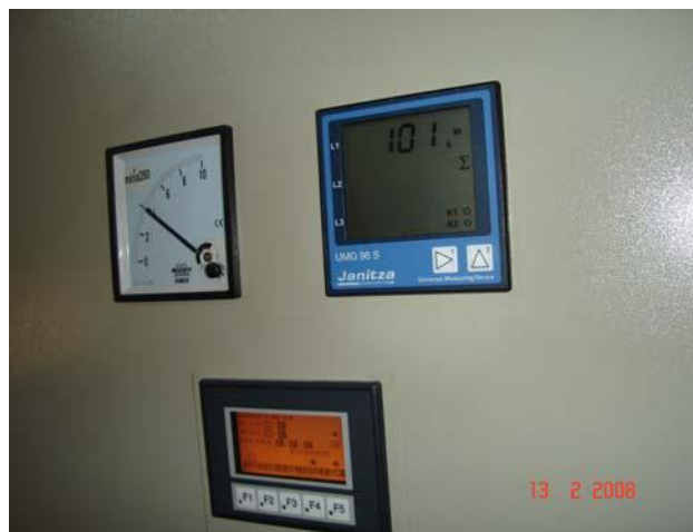
Сл. 18. Фотографија изведеног стања дела командног ормана МХЕ „Босна 1“ снаге 2 x 100 kW
