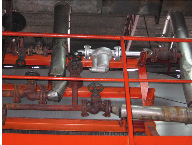
Slika 8 Izgled zamenjenog odvajача na grejaču 1 hemijske pripreme
