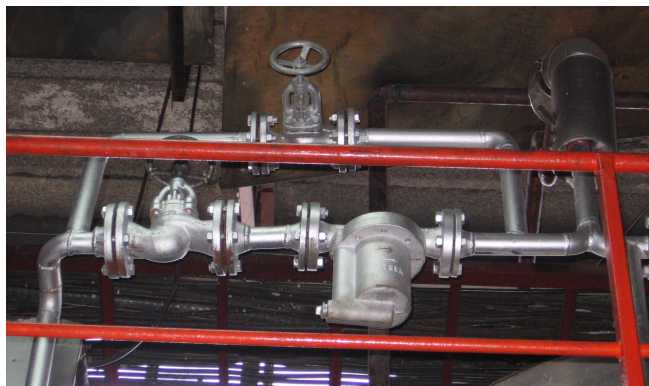
Slika 7 Izgled zamenjenog odvajача na grejaču 2 hemijske pripreme
