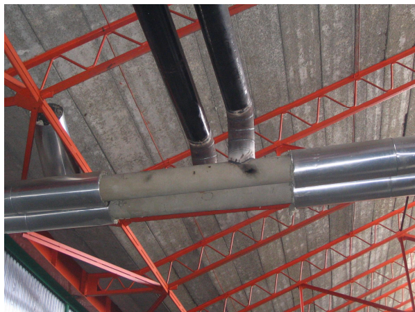
Slika 2 Prevezivanje voda TVV 300
