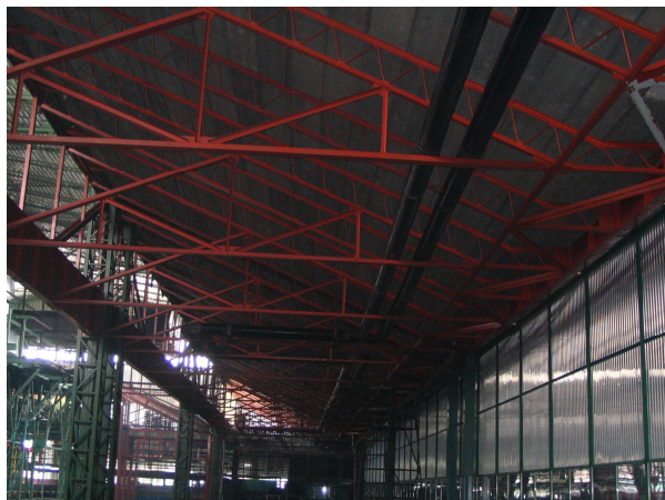
Slika 3 Izgled prevezanog voda u fazi izgradnje
