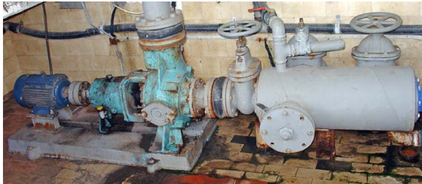
Слика 1. Пример неадекватног одржавања муљне пумпе
