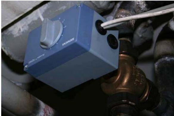
Сл. 3. Трокраки мешни вентил са континуалним моторним погоном
