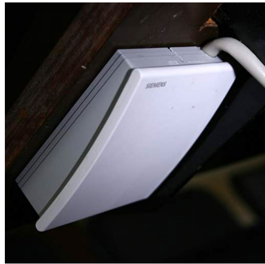
Сл. 6. Pt1000 пасивни датач температуре
