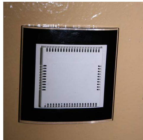
Сл. 8. Регулатор са интегрисаним датачем температуре и влажности
