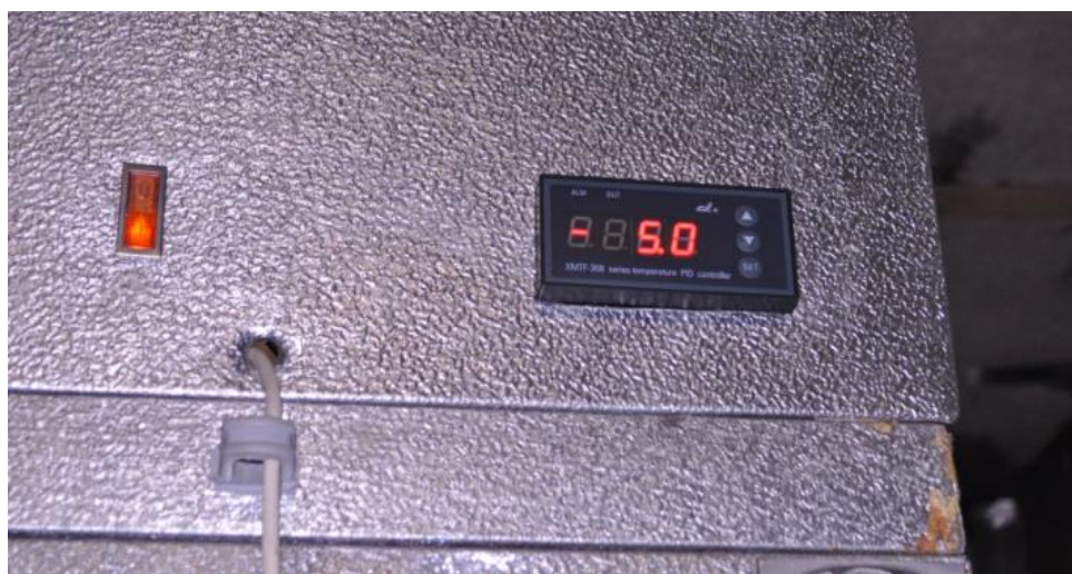
Слика 9.2. Пид регулатор XMTF-308 за одржавање температуре у клима комори
