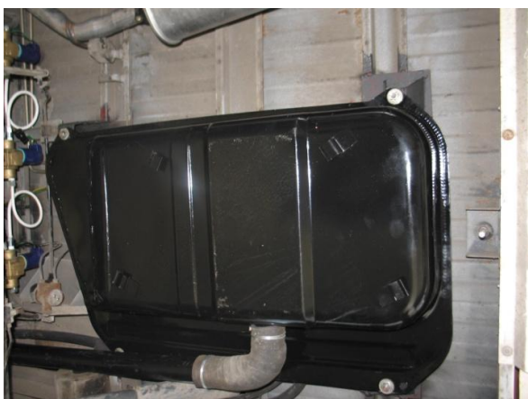
Сл.7.1 Ново место уградње резервоара за бензин
